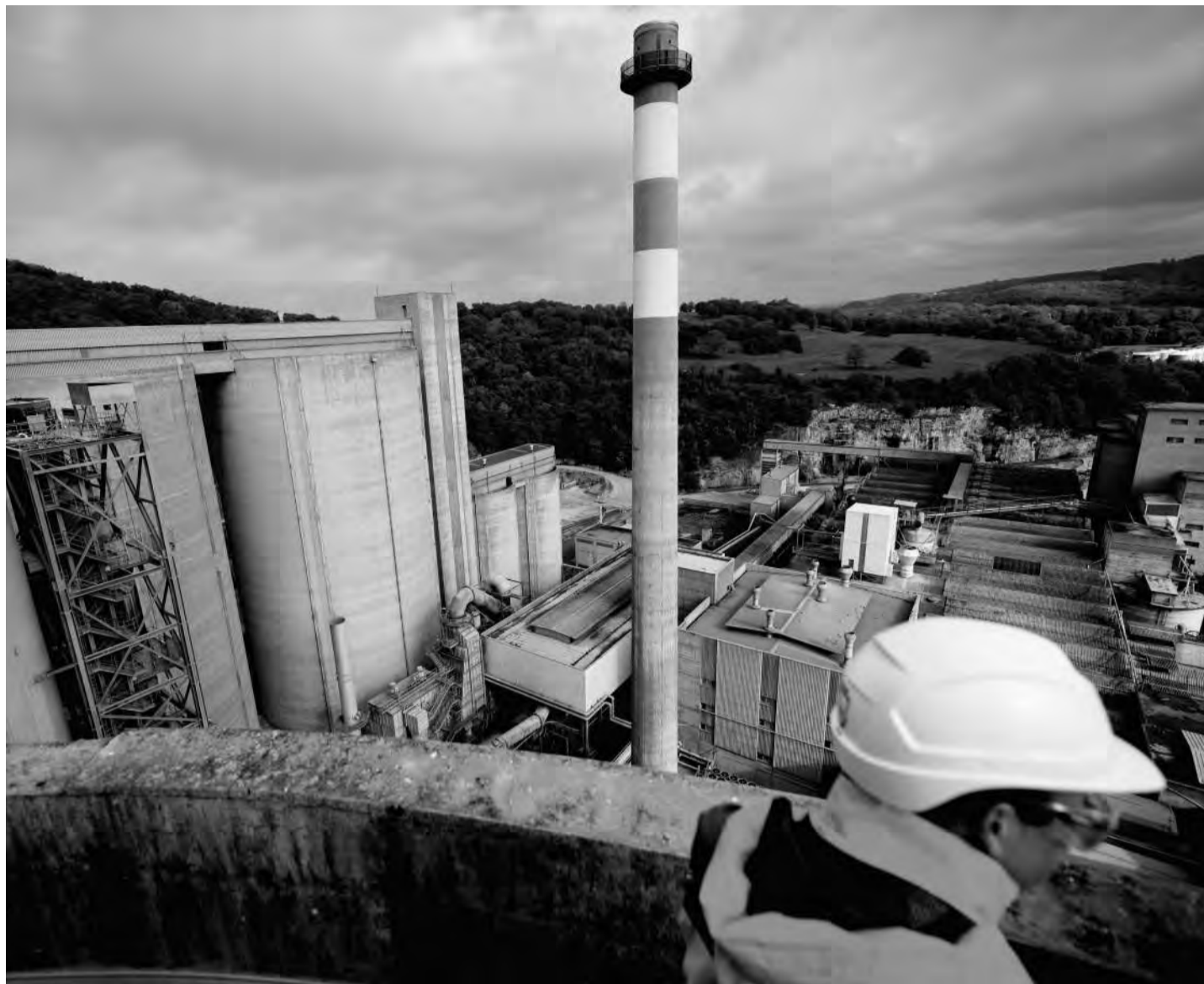
La cimenterie Holcim, près de la carrière du Mormont (VD). Pour les deux auteurs, la transformation de l'économie implique la mise à l'arrêt de nombreuses infrastructures néfastes pour l'environnement. KEYSTONE
